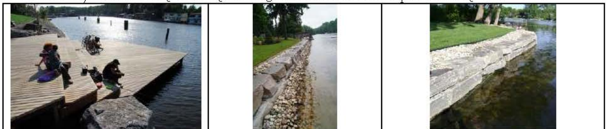
Pakrantės poilsio terasos: pakrantė palei Akmenos ežerą sutvirtinama akmenų natūraliais rieduliais (pakeičiant esamą tarpais išvirtusią gelžbetoninę sienutę), įrengiamos poilsio vietos, kurios formuojamos iš didelių natūralių akmenų, betono ir medžio kompozito terasų.
